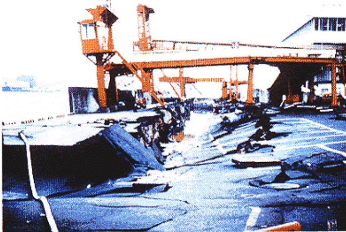
1-1-5 図 神戸港被災写真 (六甲アイランド地区)
